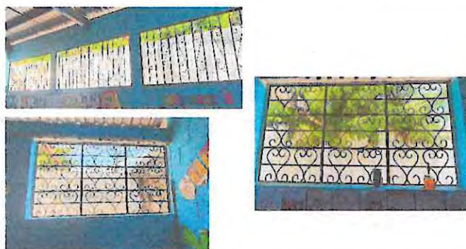
Foto 3: Ventanas de tres aulas
