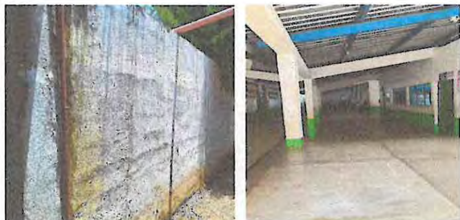
Foto1: Muro perimetral y corredor de las aulas
