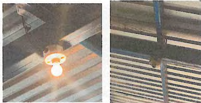
Foto 4: Focos de aulas y corredor
