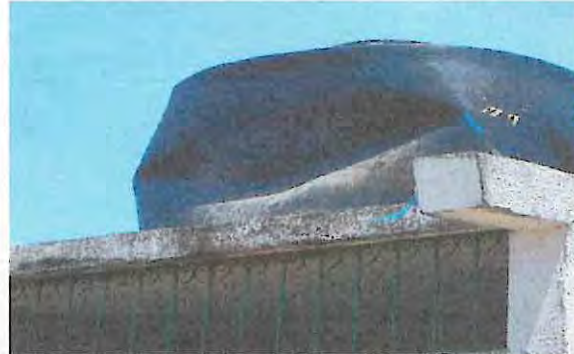
Foto 2: Deposito de agua
